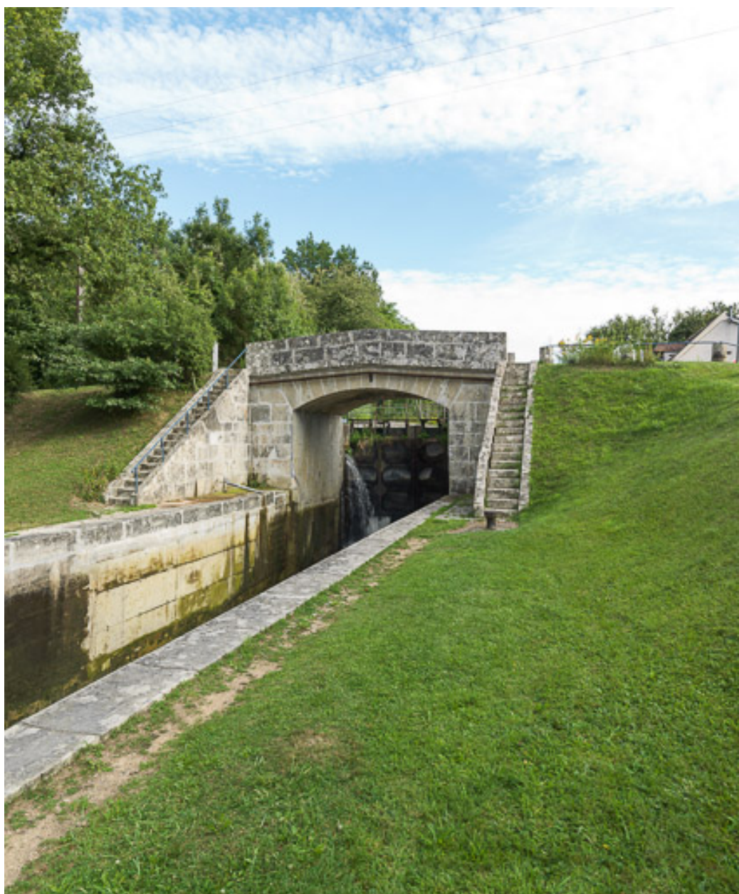
Vue d'ensemble du pont.
