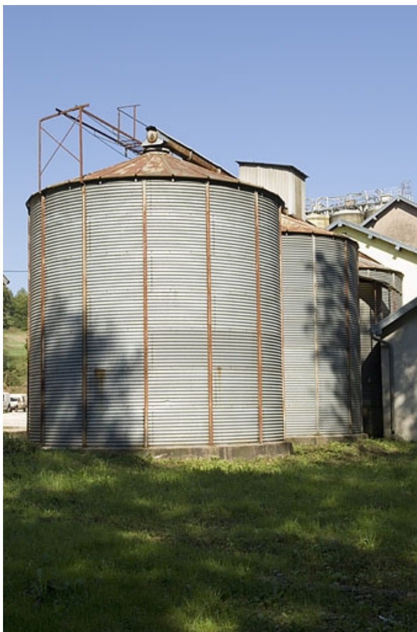
Silos métalliques. Vue depuis l'ouest.
