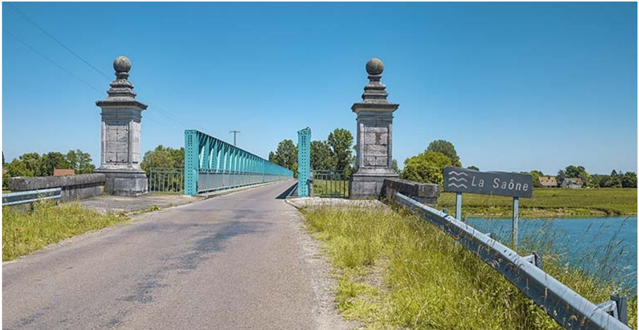
Entrée du pont.
