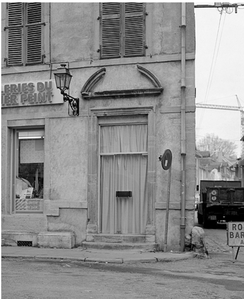
Façade antérieure, porte d'entrée.
