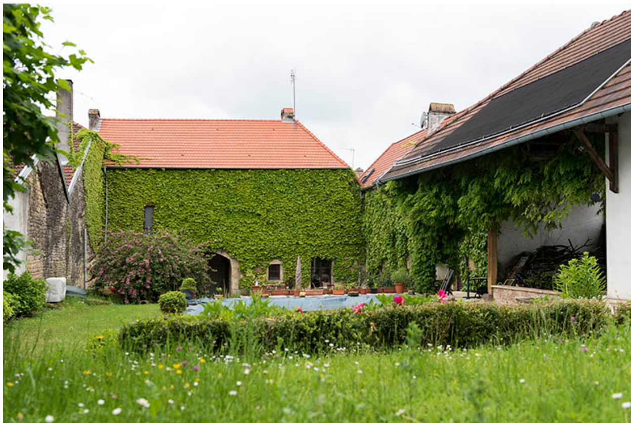
Vue générale de la cour intérieure.
