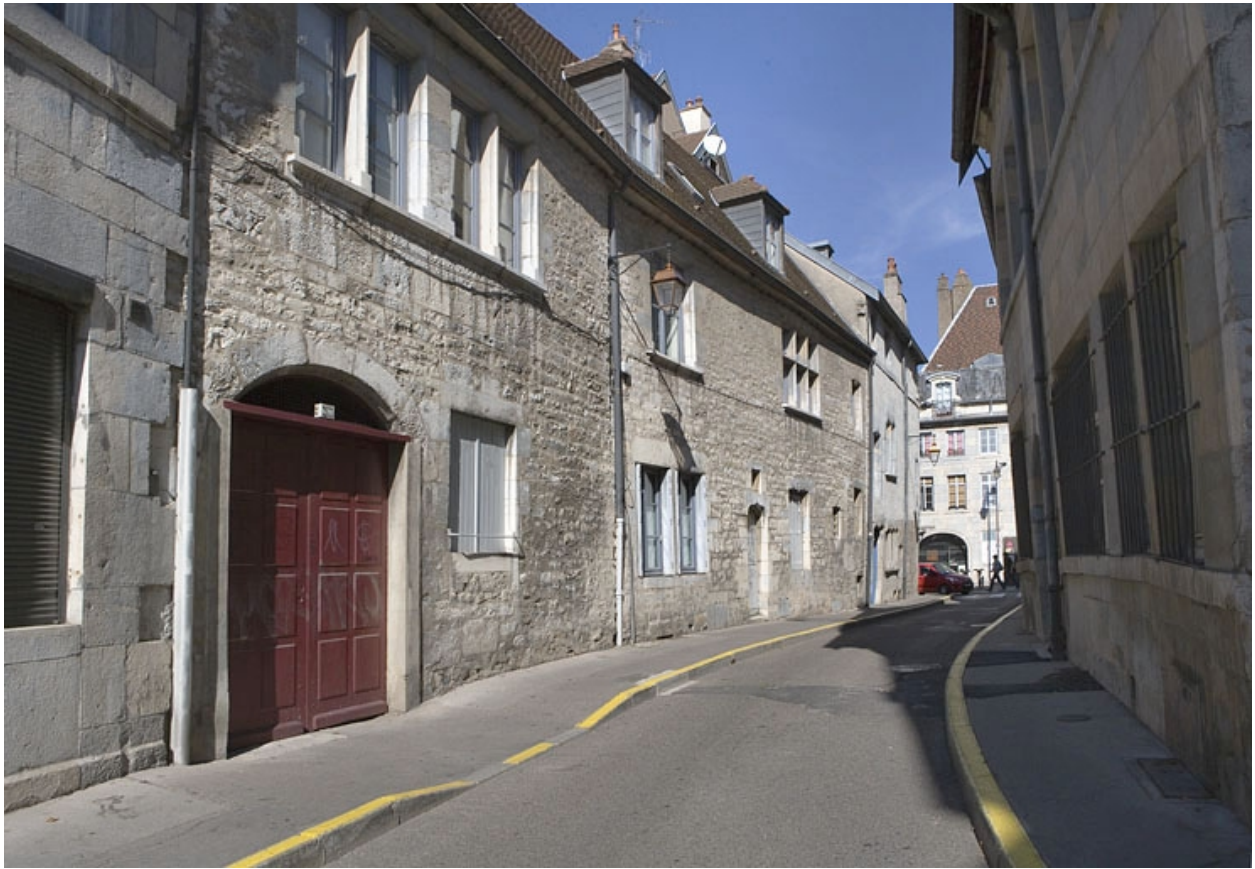
Façade latérale gauche, vue d'ensemble.
