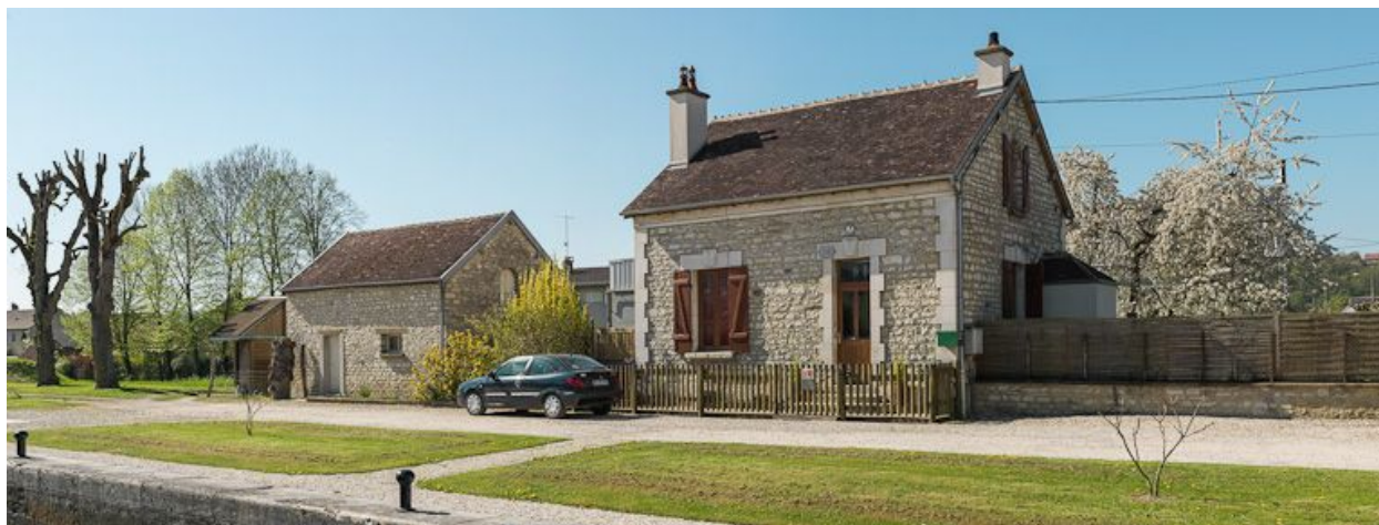
Vue d'ensemble de la maison éclusière.
