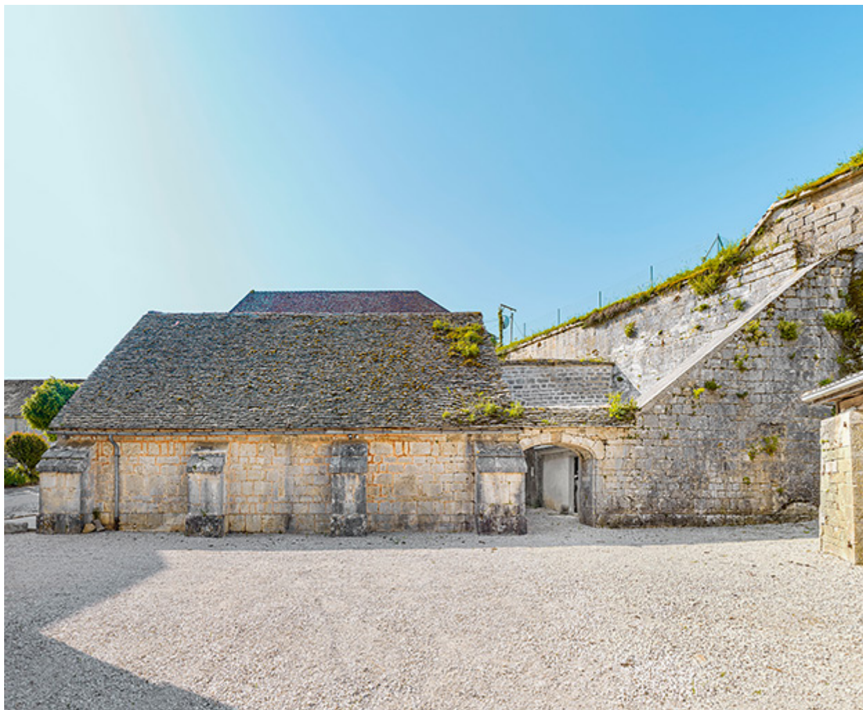
Vue latérale nord.
