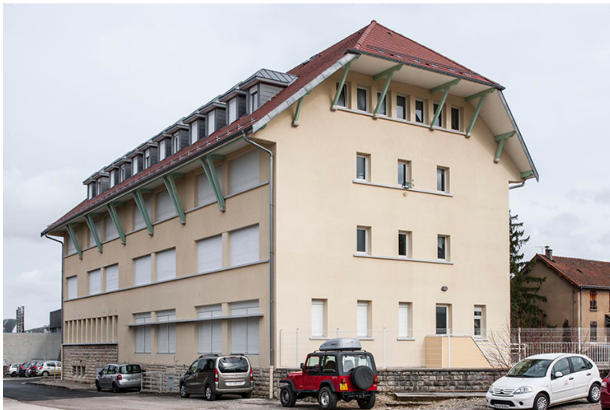
Angle sud-ouest et pignon sud de l'internat.
