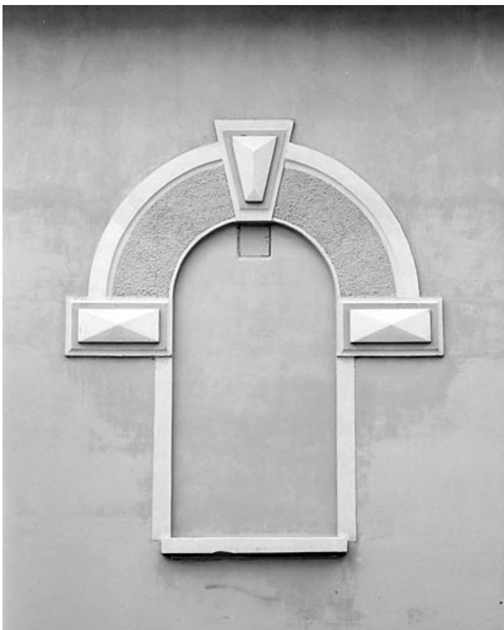
Détail d'une baie.
