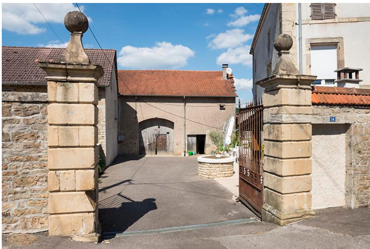
Le portail avec ses piliers.
