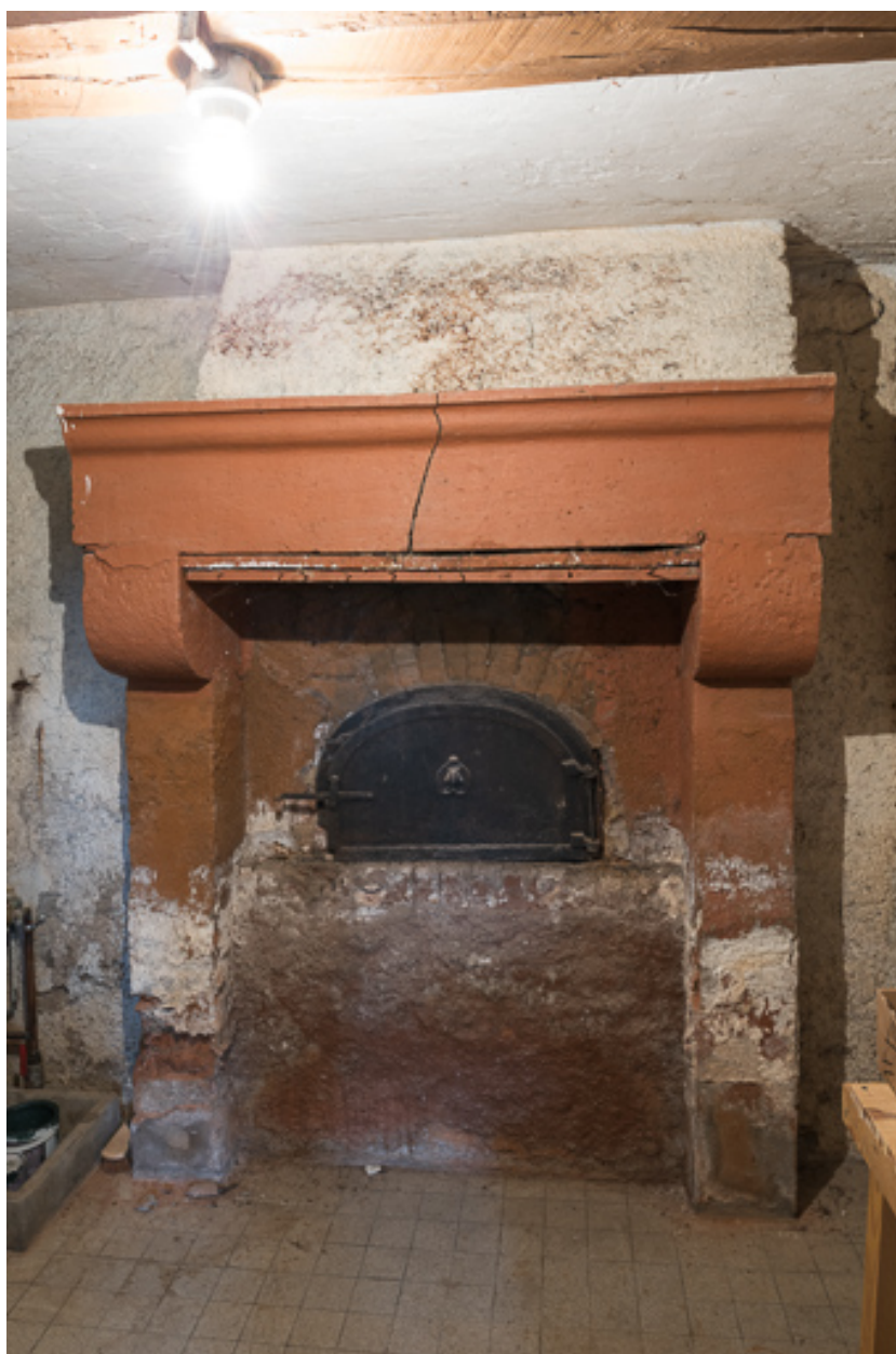
Vue de l'ancien four à pain
