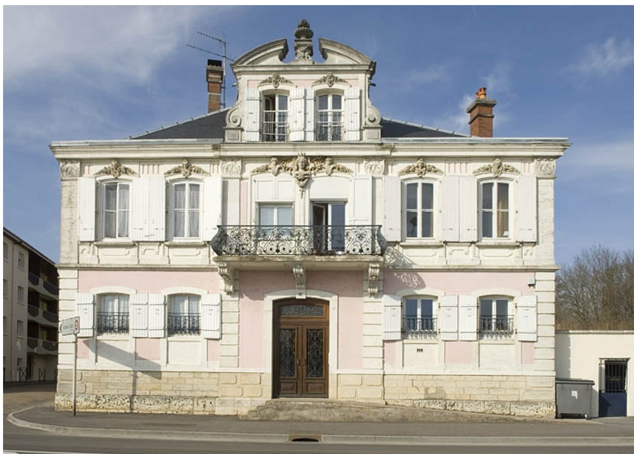
Vinaigrierie Clémentz : pignon du logement patronal.
