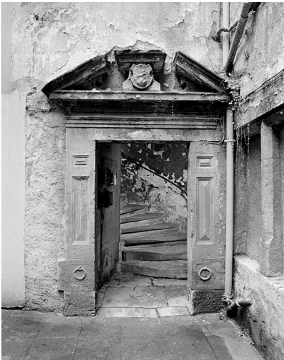
Porte de la tour d'escalier.
