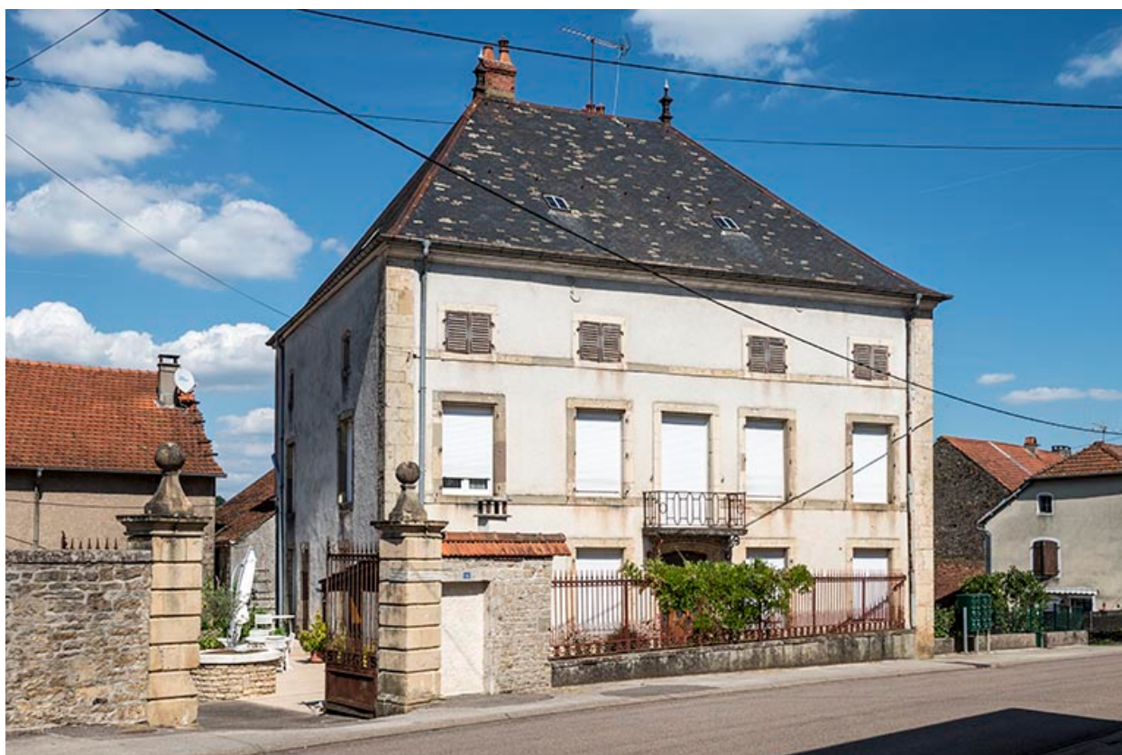
La façade antérieure.
