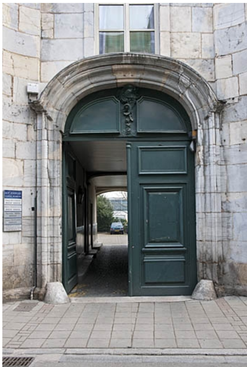
Façade antérieure de l'hôtel : détail du portail.
