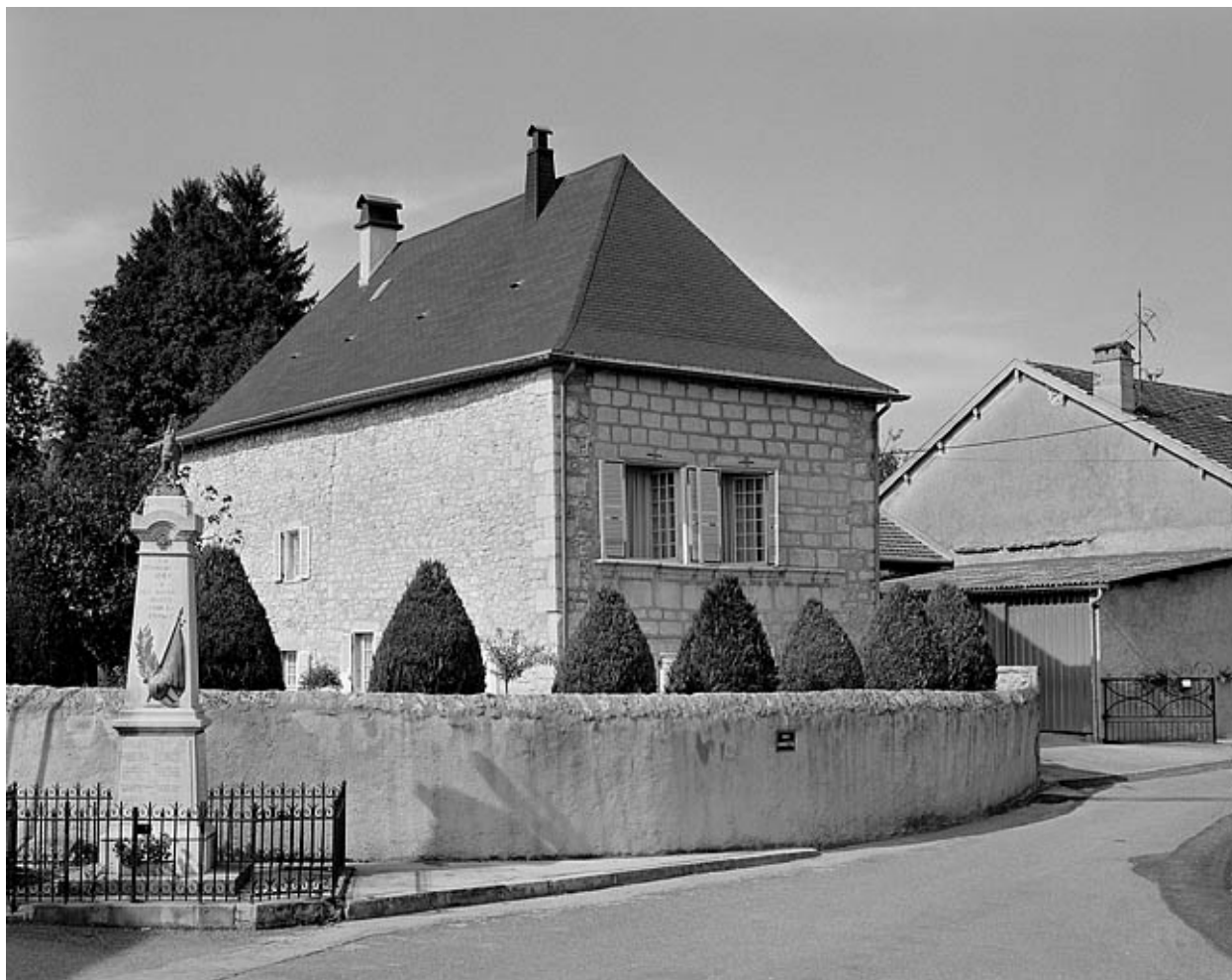
Demeure de notable dite le Château.
