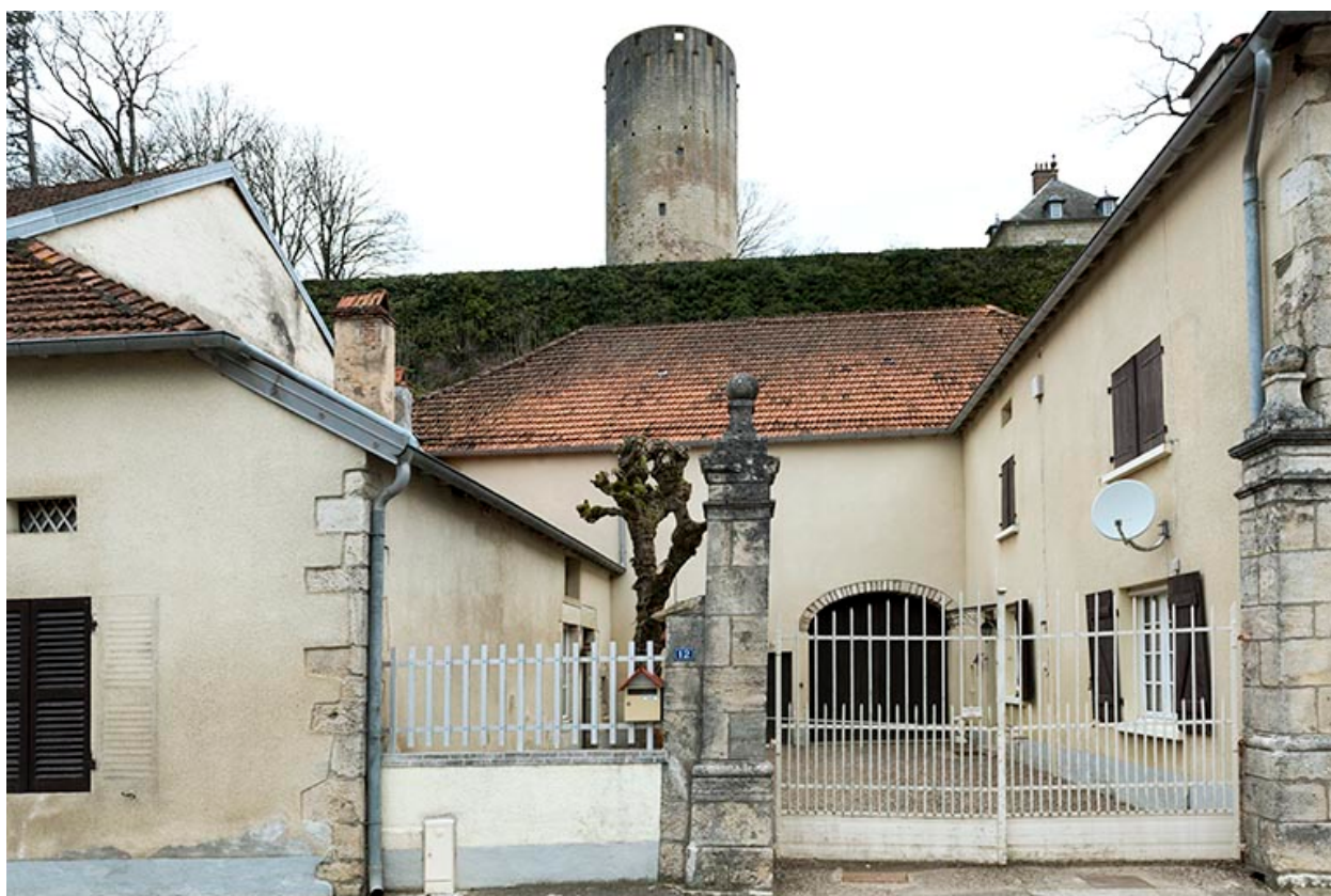
Vue générale depuis la rue du Pâquis
