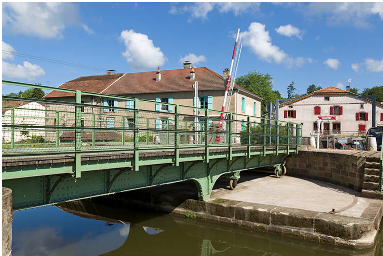
Le tablier métallique et sa plateforme.
