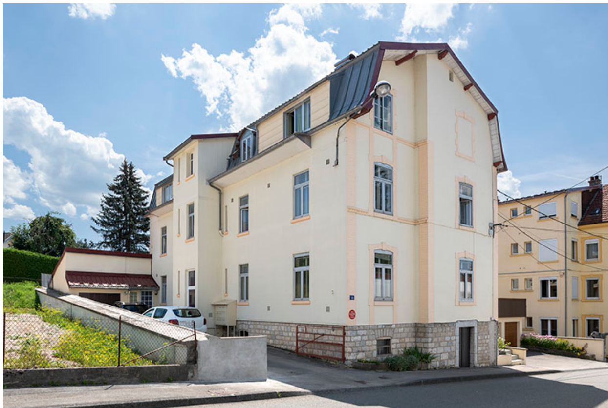
Façades postérieure et latérale gauche.
