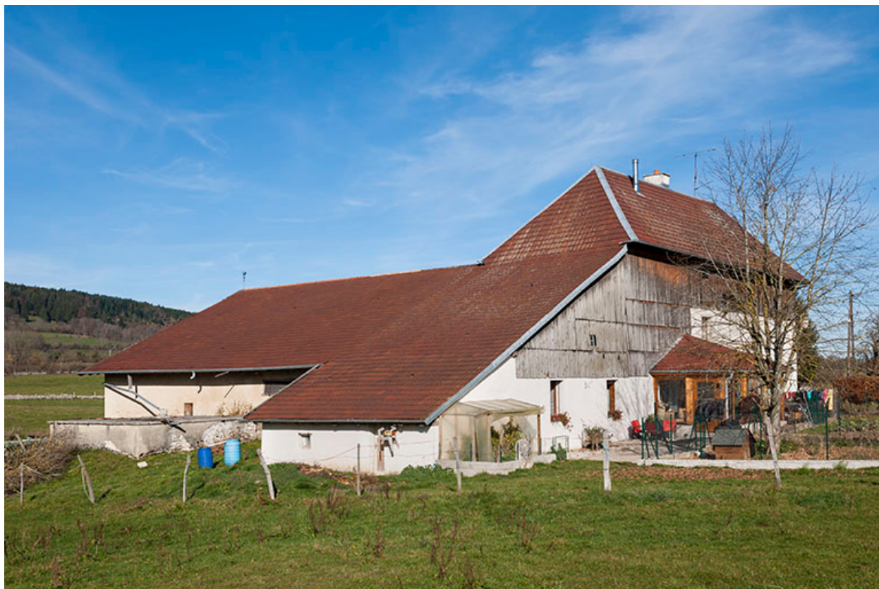
Ferme : façades sud et ouest.
