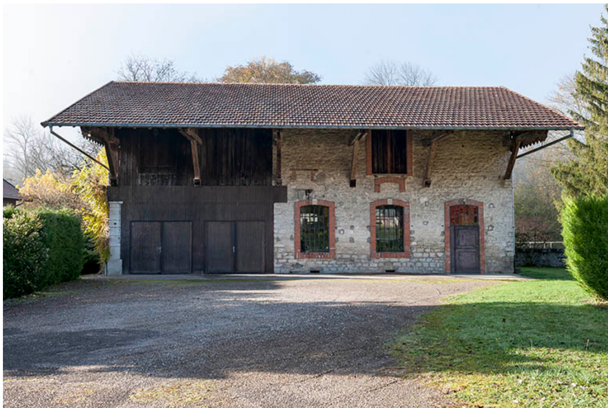
Entrepôt industriel. Face est.
