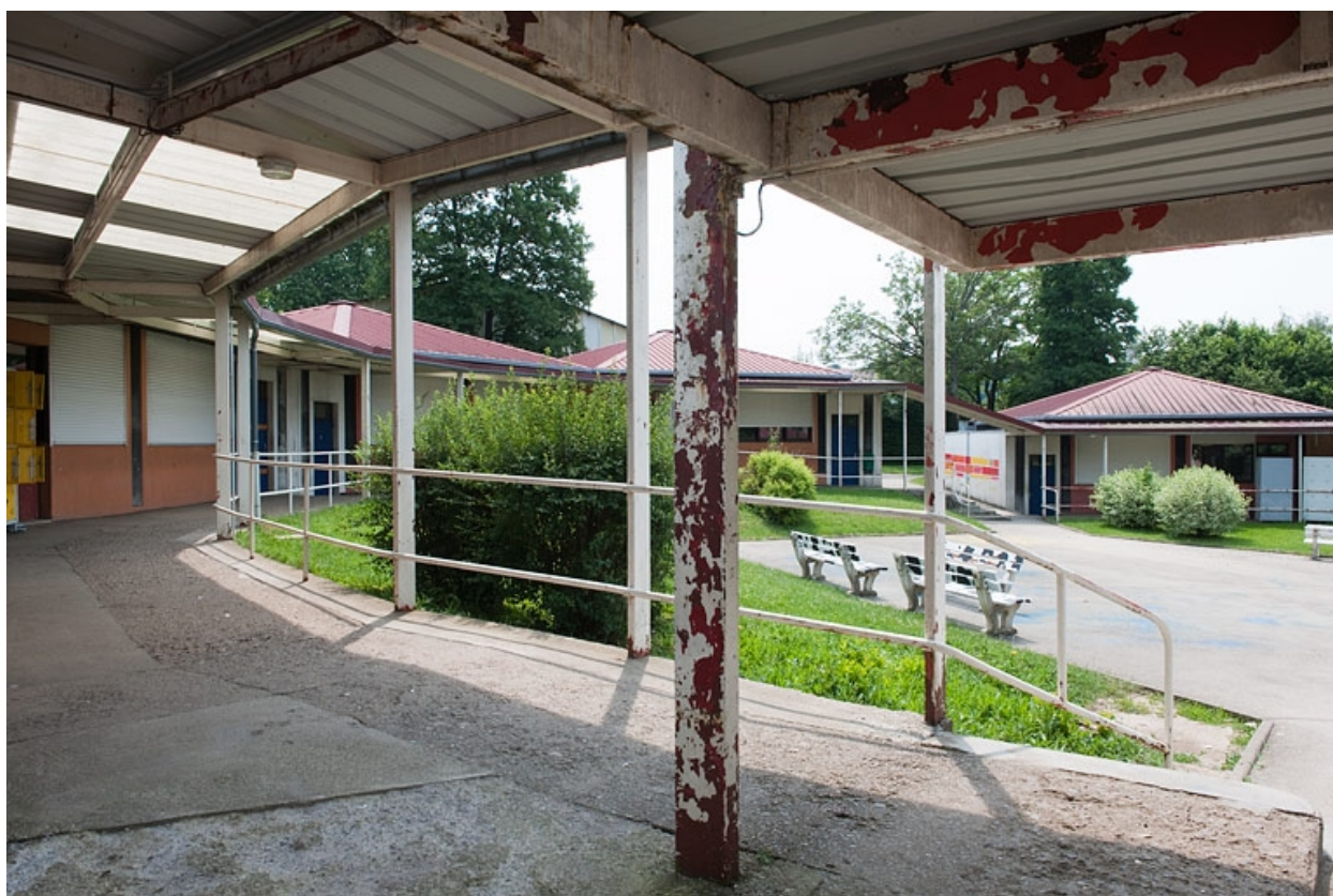
Vue générale de la galerie couverte.
