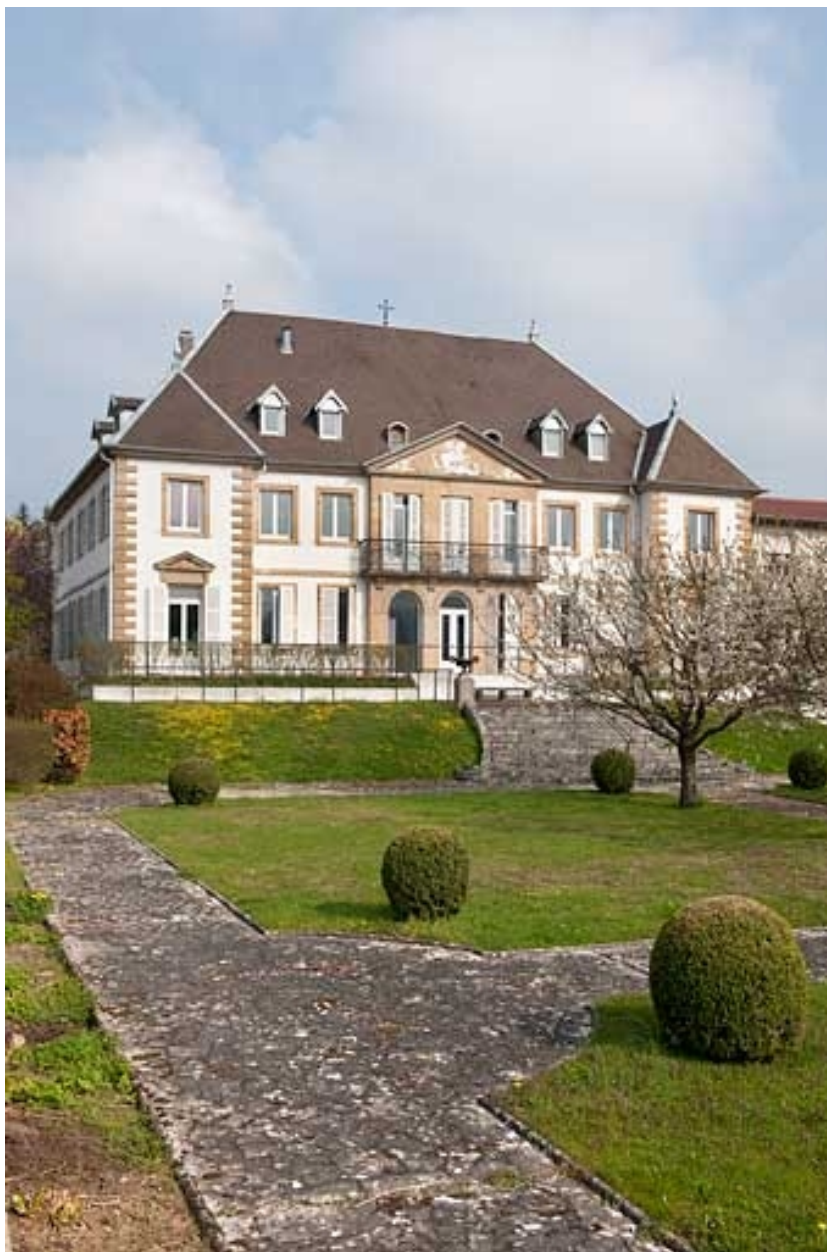
Façade antérieure depuis le jardin.
