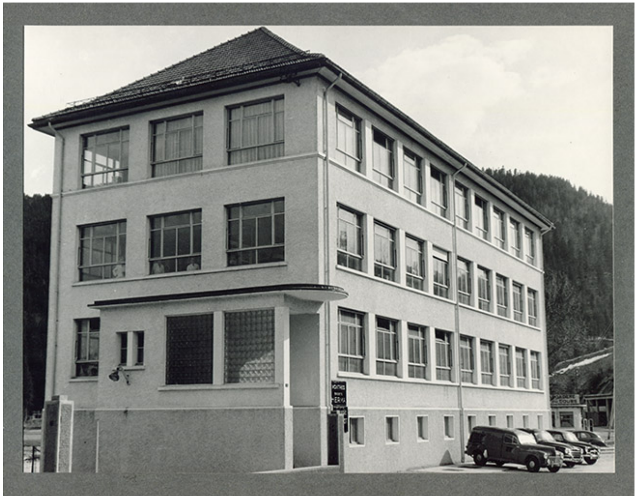
Façades antérieure et latérale gauche, années 1960.
