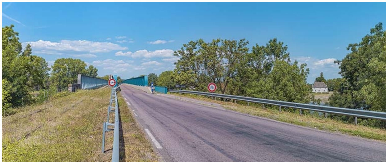
Vue d'ensemble des deux voies du pont.
