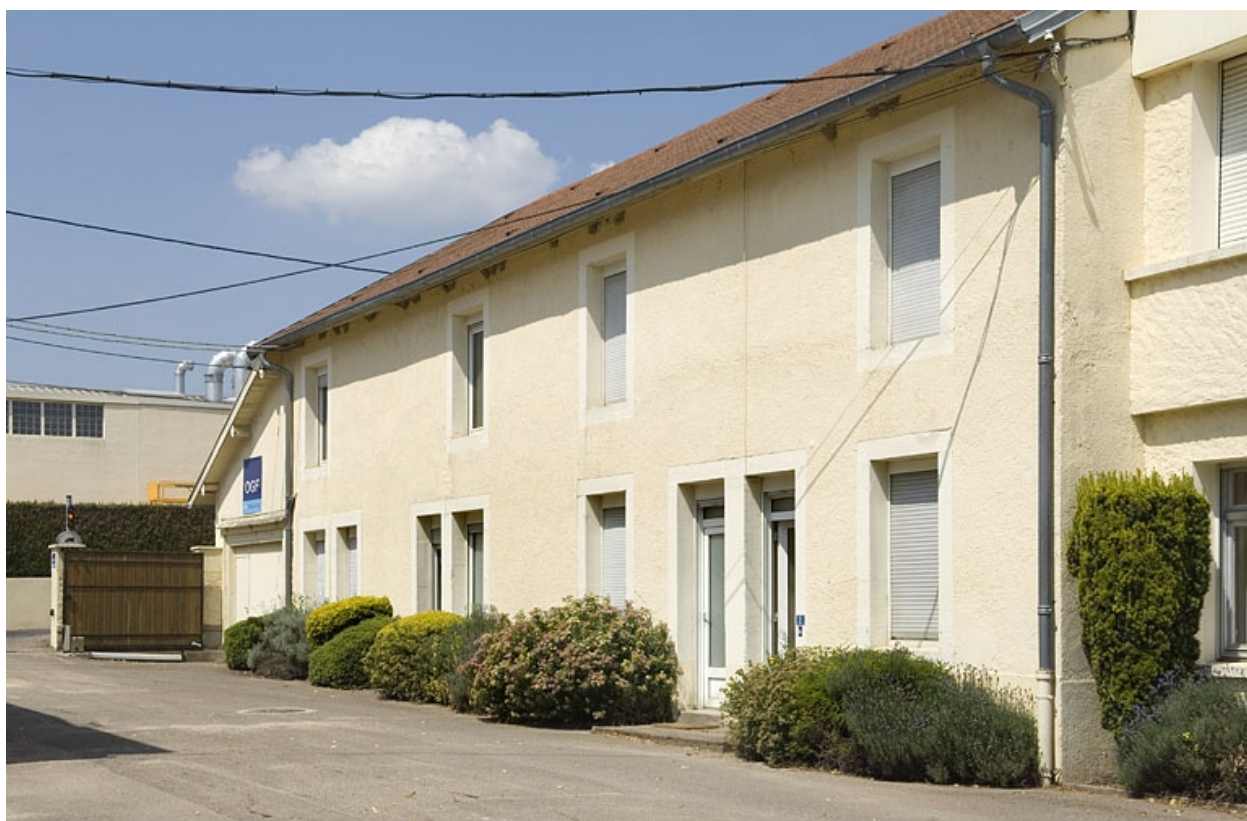
Façade ouest des logements.
