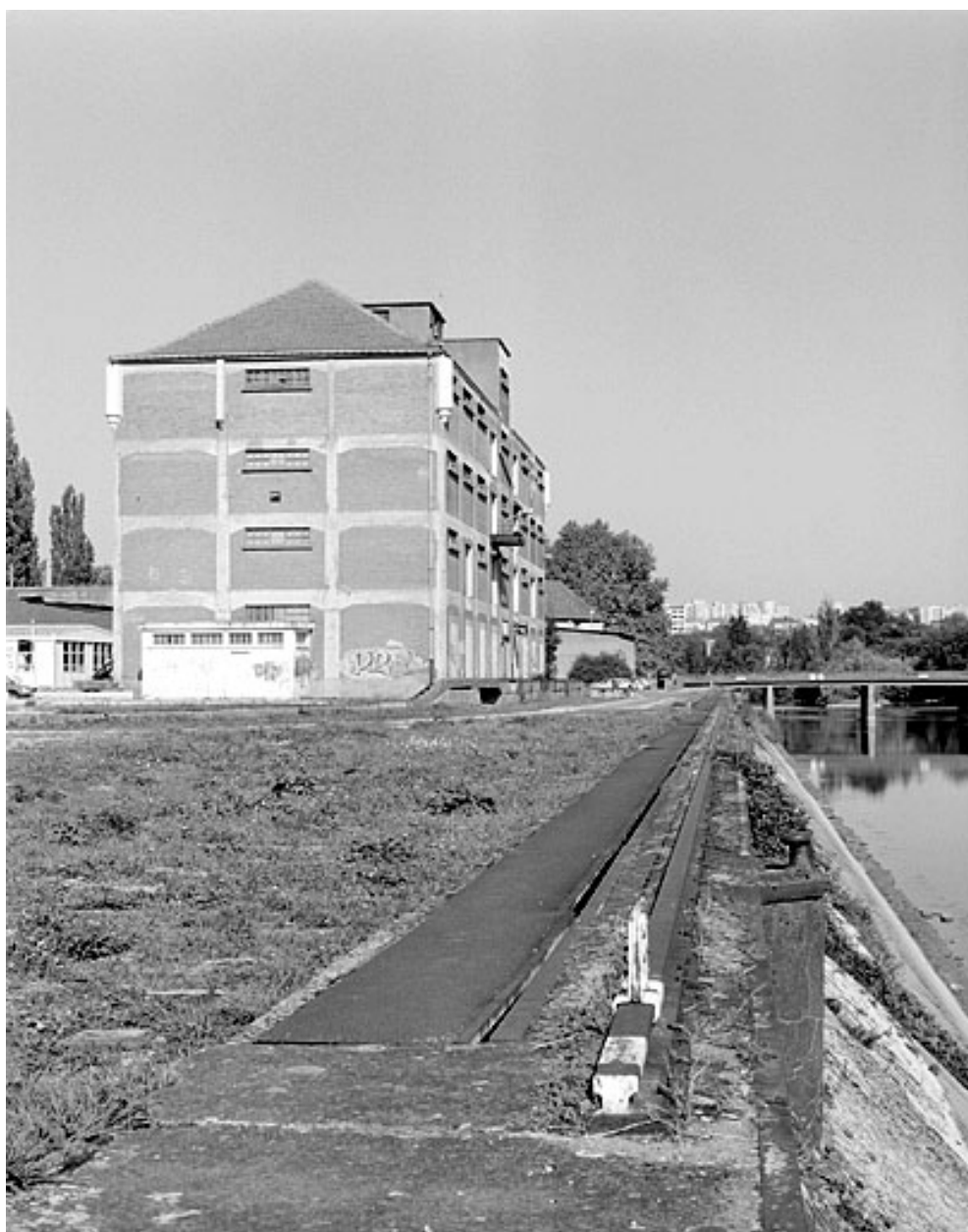
Entrepôt et quai, depuis l'amont (vue rapprochée)
