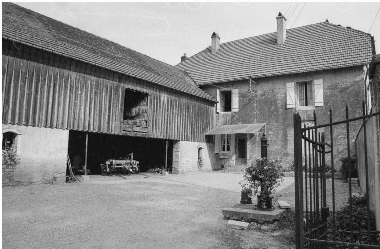
L'habitation : façade sur cour gauche.
