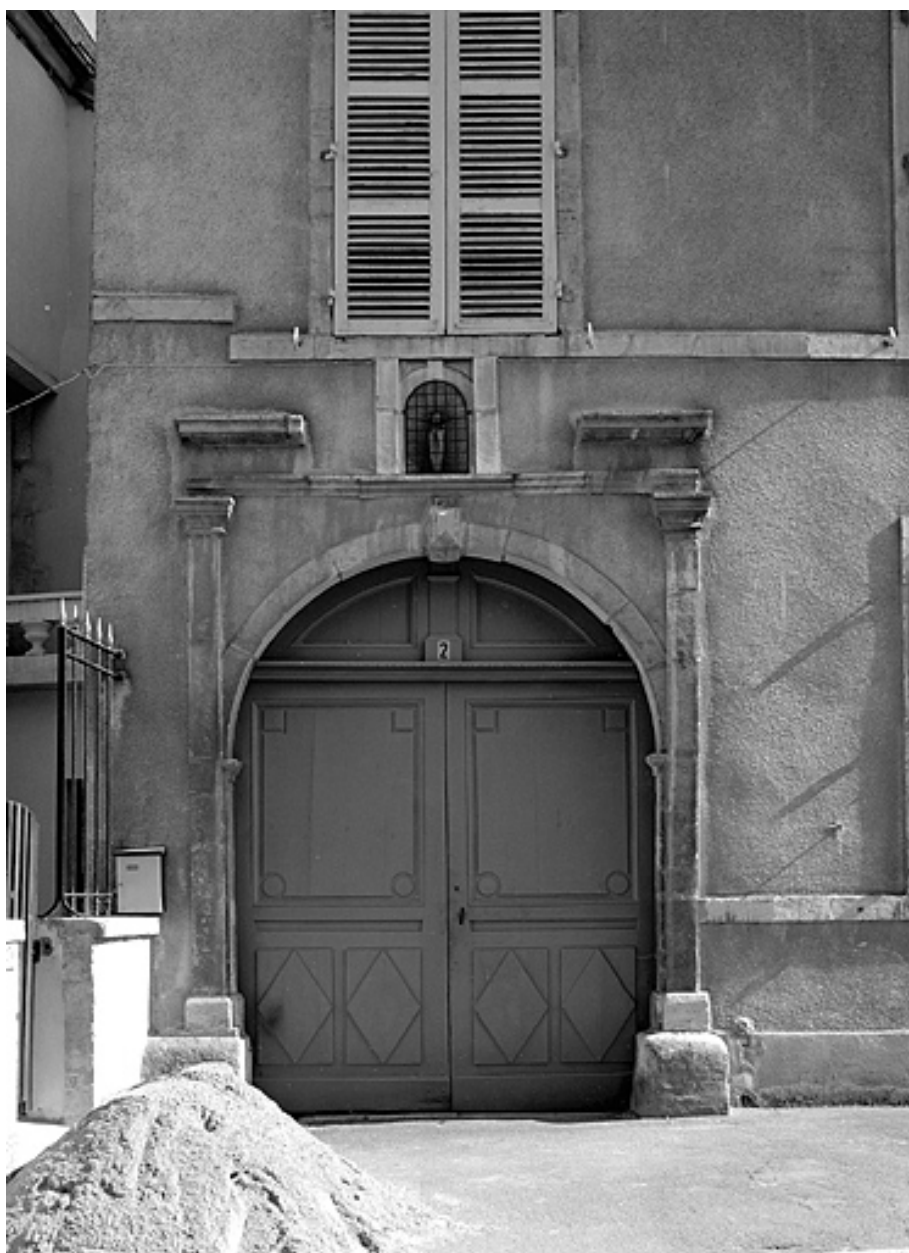
Détail du portail d'entrée.
