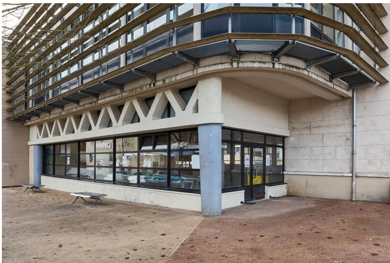
Façade latérale gauche : baies du marché.
