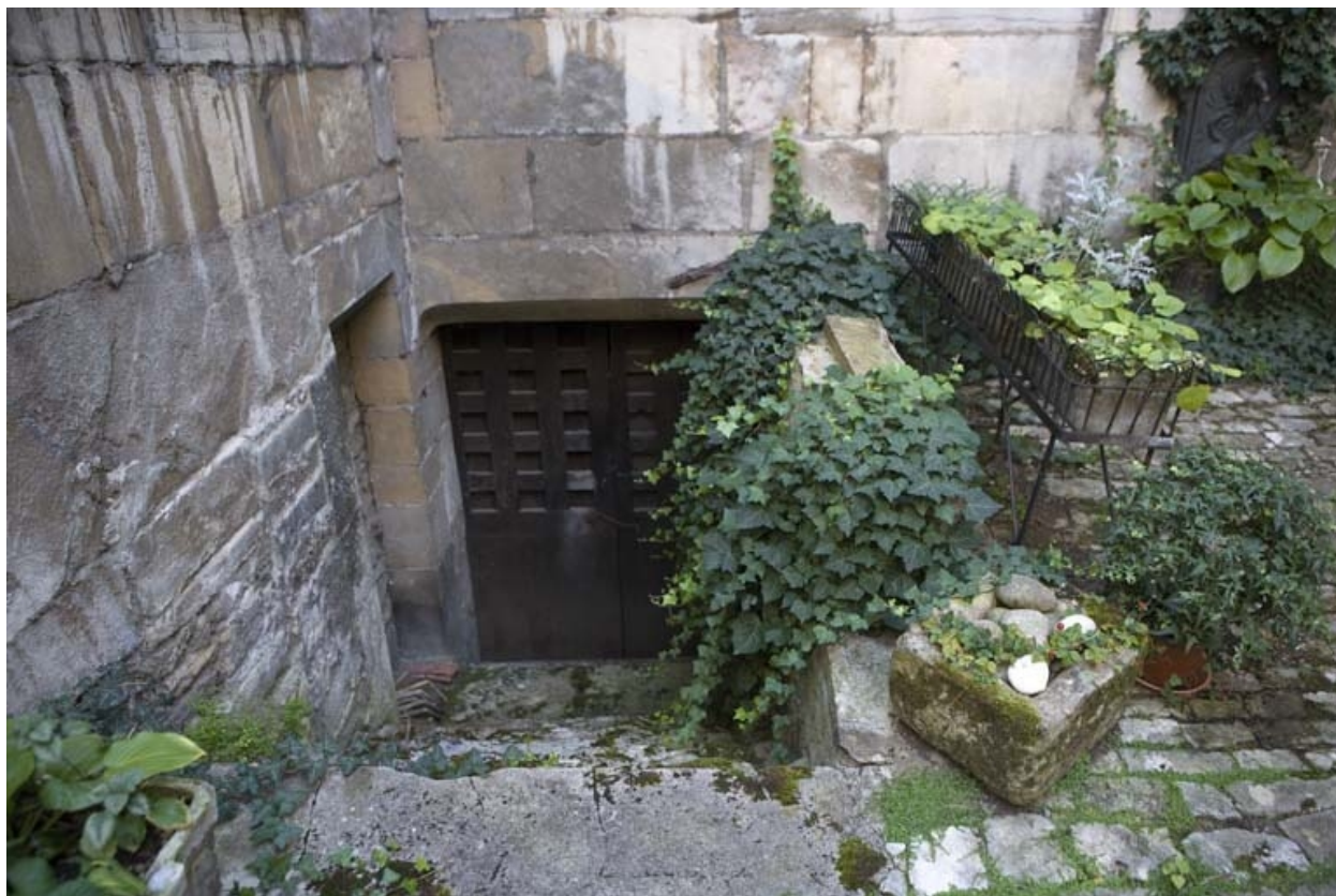
Façade postérieure du logis : entrée de cave.
