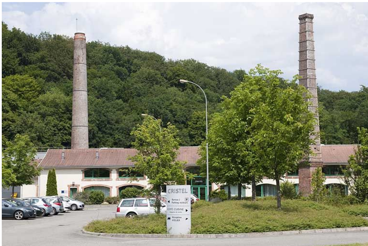
L'usine depuis l'entrée du site.
