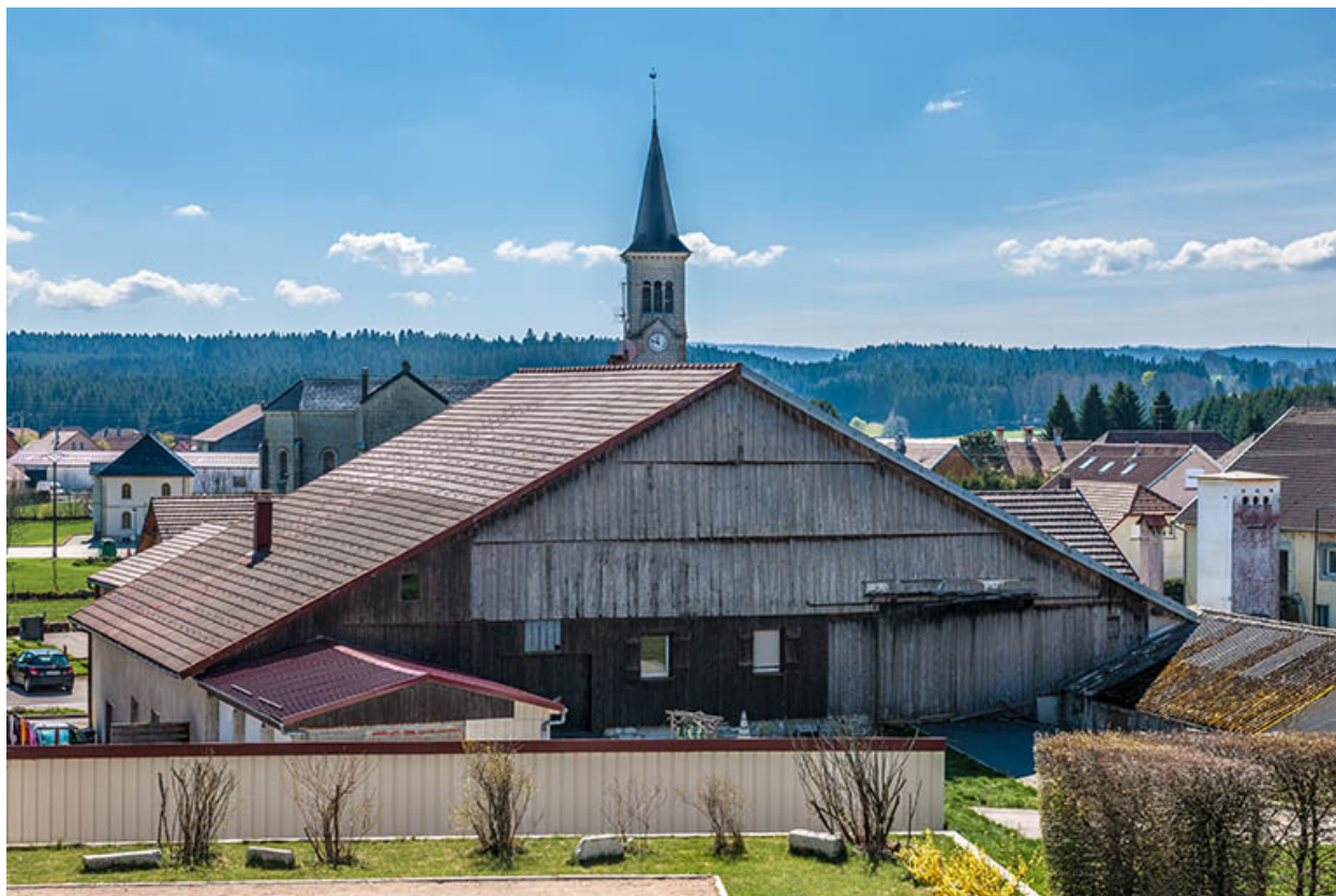
Ferme : façade postérieure.
