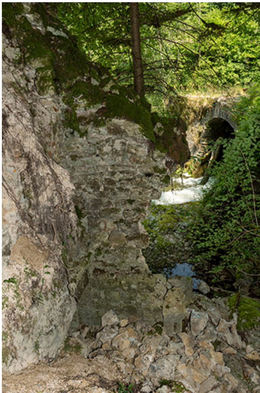
Ruines de la scierie Vadam, sur la rive droite.
