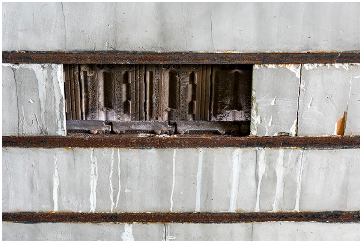
Atelier de fabrication (ancienne tréfilerie) : hourdis de briques plâtrées maintenues par la charpente métallique.
