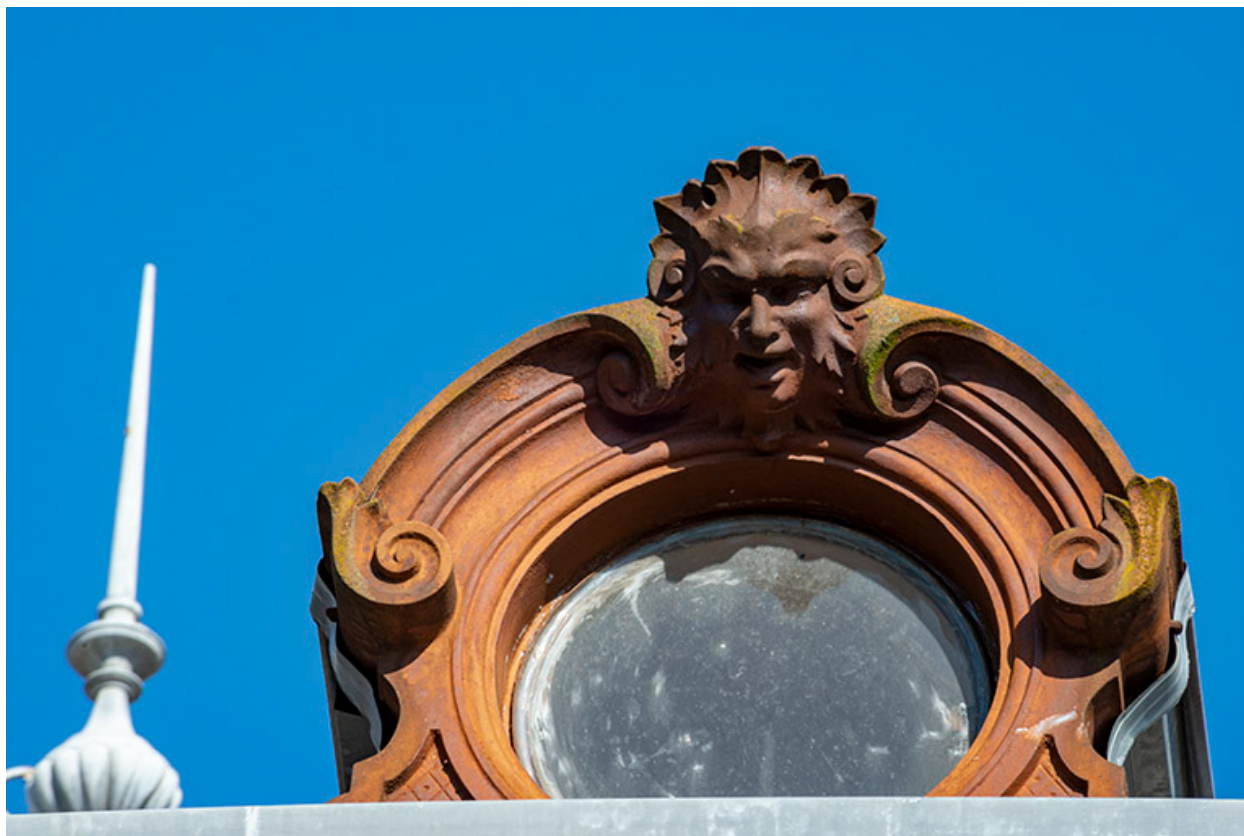
Détail de la lucarne.
