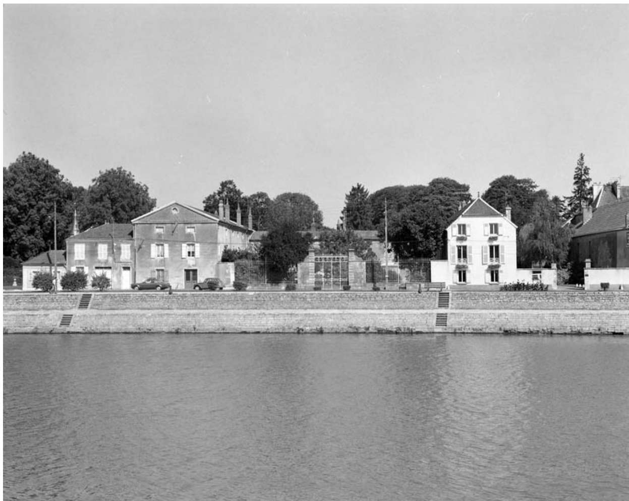
Vue d'ensemble depuis le quai Mavia.
