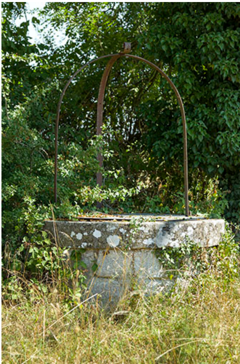
Puits dépendant du site d'écluse.
