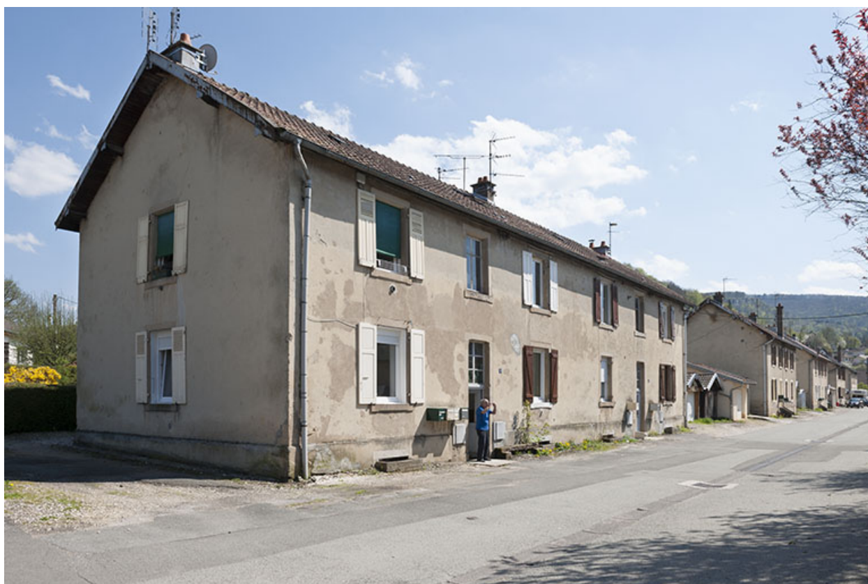
Façades ouest des habitations (côté impair).
