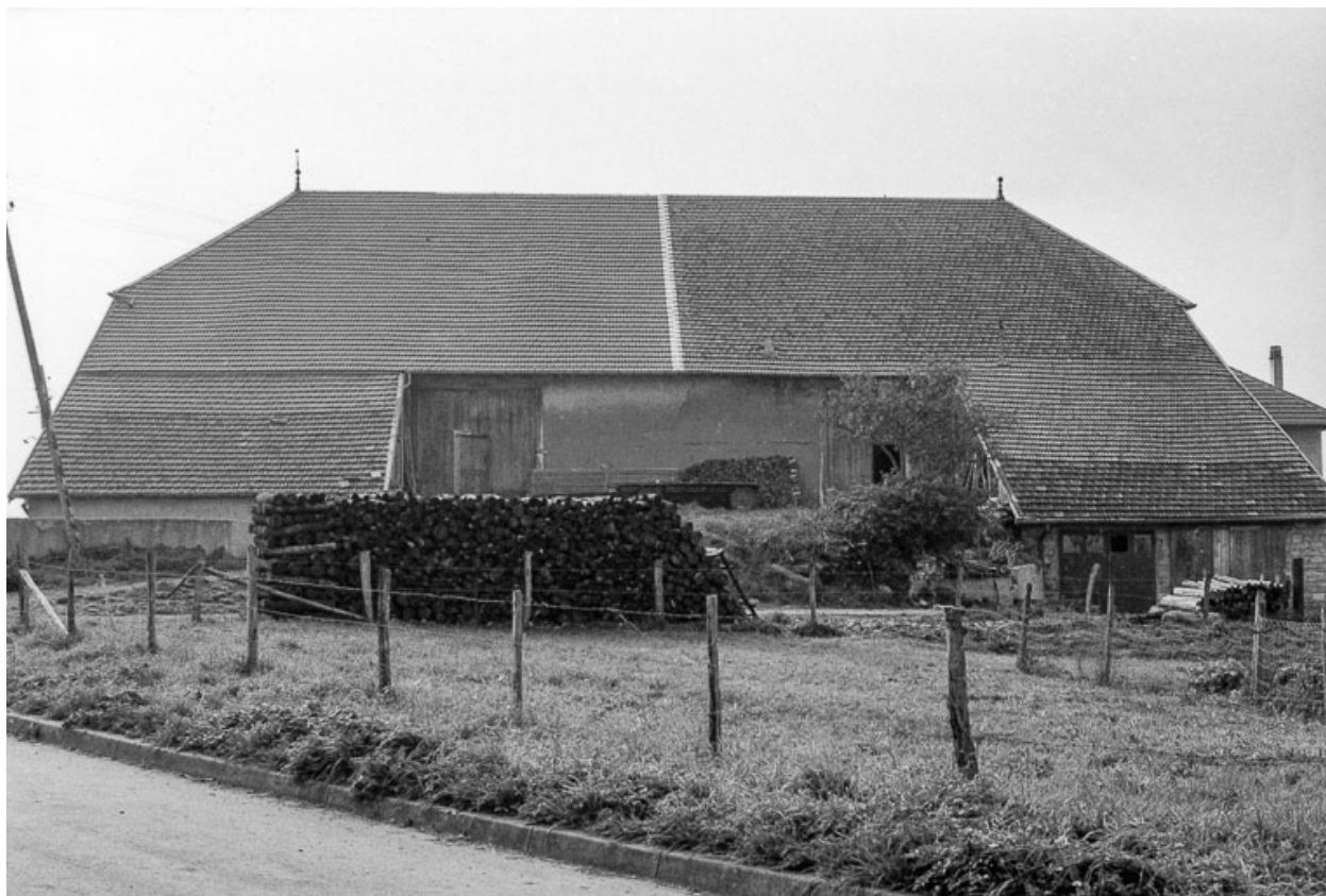
Ferme double : façade postérieure.
