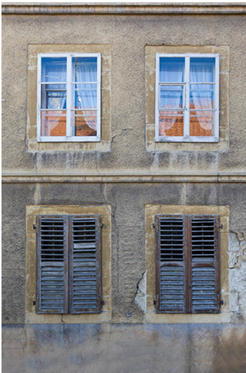
Maison : fenêtre de la façade antérieure.
