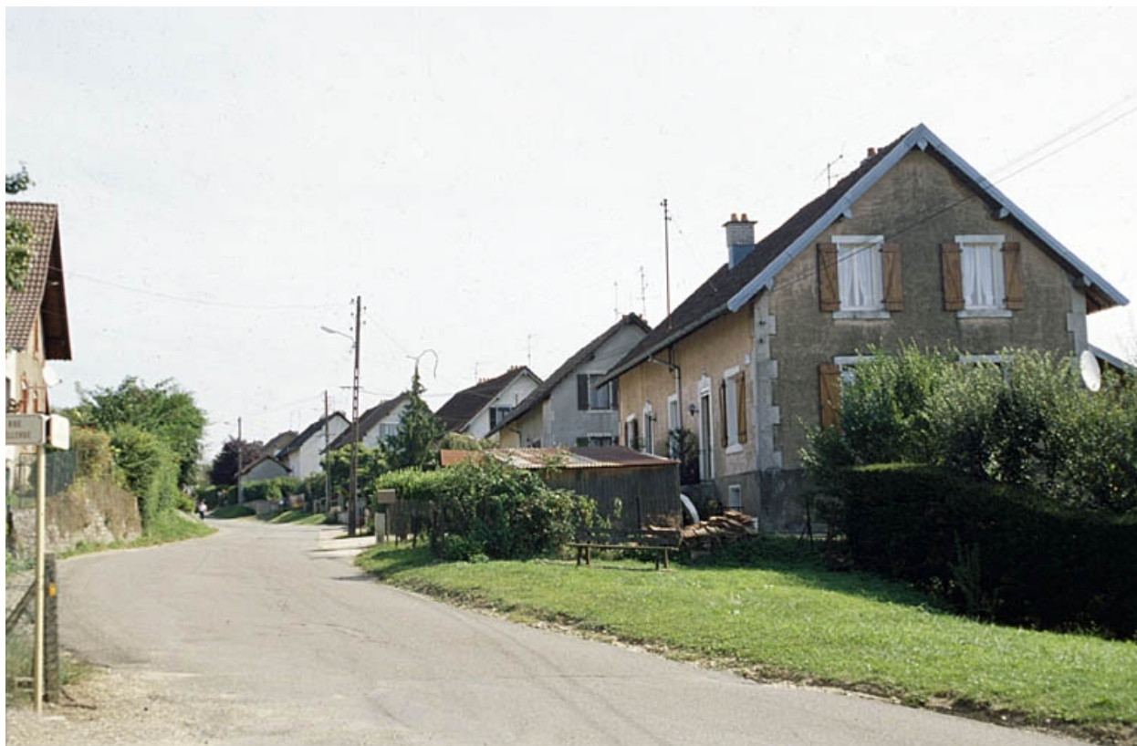
Logements ouvriers rue du Bois Lachat.
