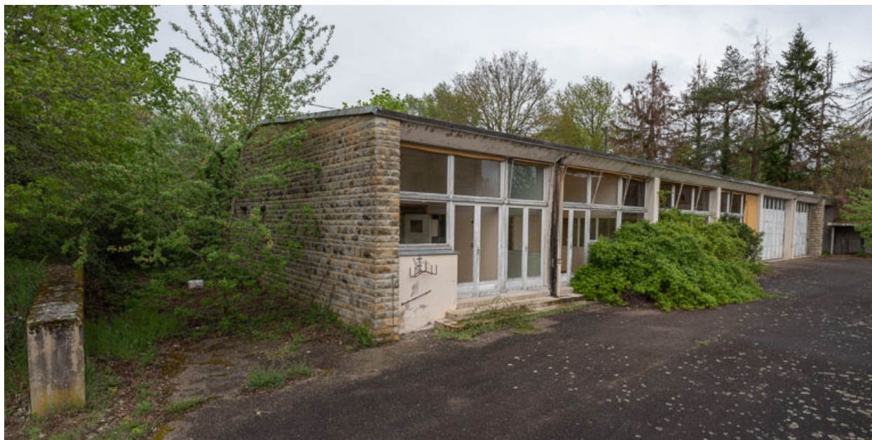
Bâtiment des garages et des ateliers.
