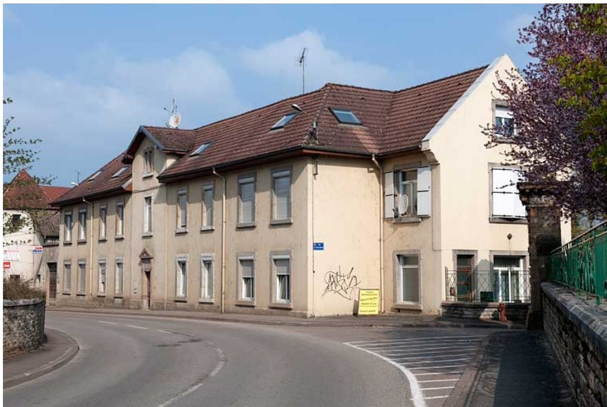
Vue générale de l'ancien pavillon d'isolement.
