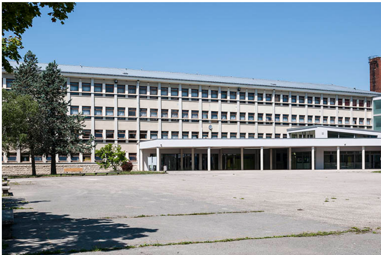
Vue de la façade postérieure de l'internat.
