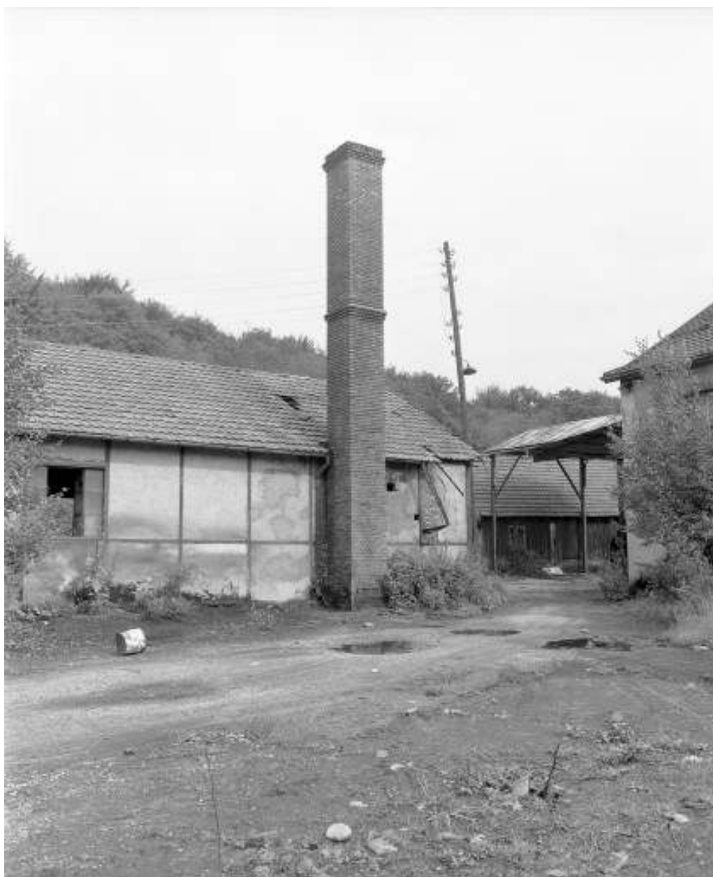
La chaufferie et sa cheminée en 1981.
