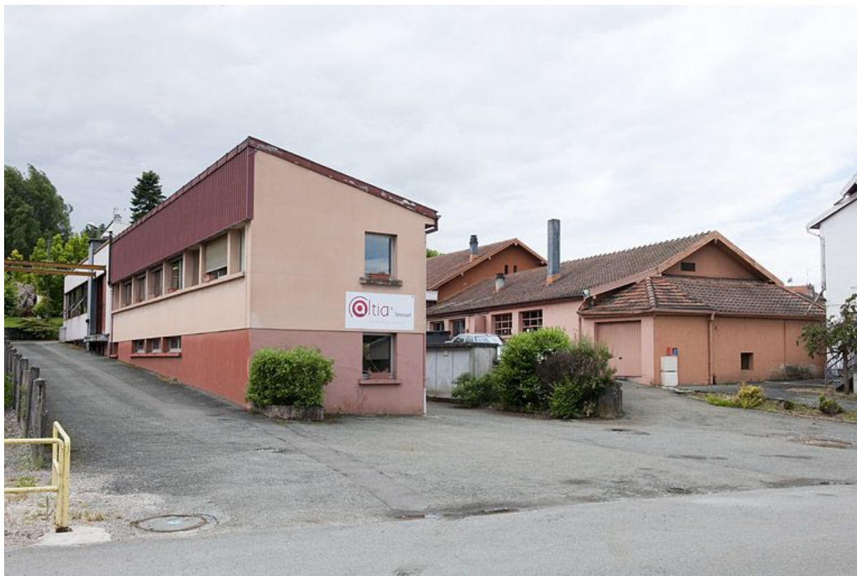
Vue d'ensemble depuis la rue.
