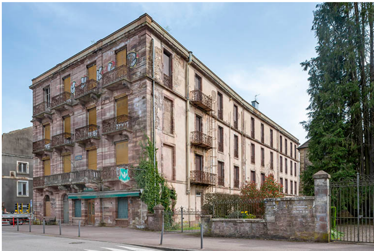
Vue d'ensemble depuis la rue des Thermes.
