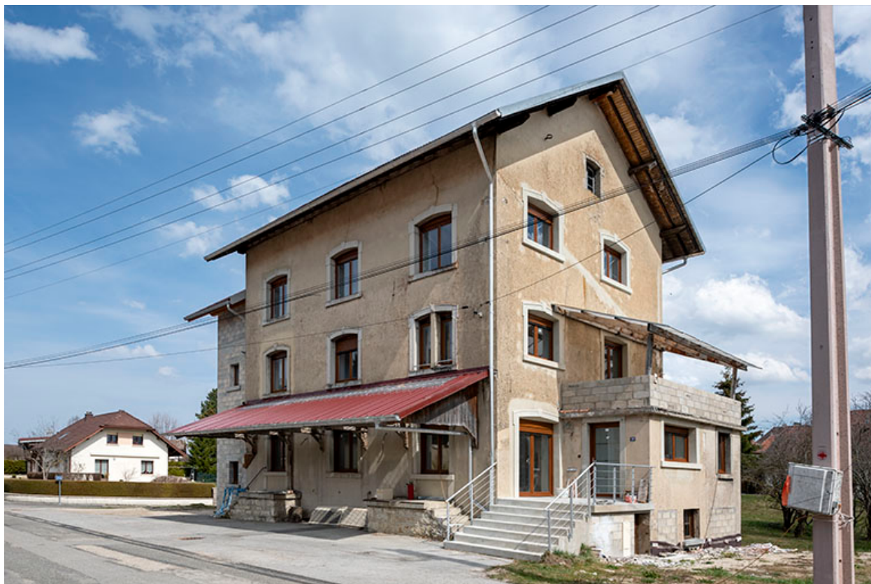
Façades antérieure et latérale droite.
